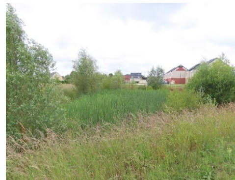
Noue pour les eaux pluviales près du stade
