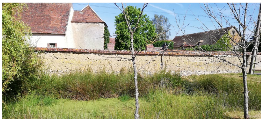
Mur rue de Valpinçon près de la mare
