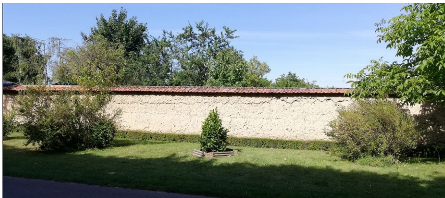
Mur haut en bauge surmonté d'un chaperon en tuile
