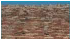
Le faitage des toitures en tuile.
