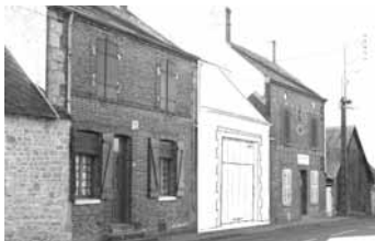
Après : mise en valeur de la baie
