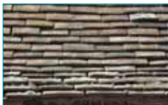
Toit débordant en tuile.
