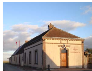
La mairie de Prudemanche, décor de brique, maçonnerie enduite
