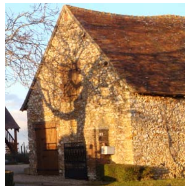
Maçonnerie en moellon calcaire
