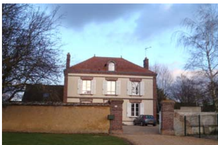
Une demeure bourgeoise R+1, en retrait d'alignement, chaîne d'angle en brique, couverture en tuile
