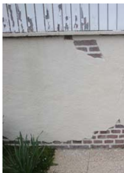
Un mur de brique enduit à la chaux
