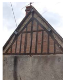
La partie supérieure d'un pignon en pans de bois
