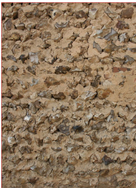
Maçonnerie de silex
