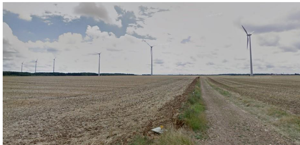
Le parc éolien du Chemin de Tuleras (source : Google Street View, 2013)
