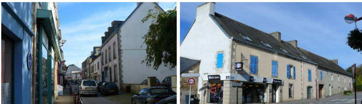
Les rues étroites commerçantes (commerces en rez-de-chaussée) du centre ancien. Elles sont soulignées d'un alignement de façades. Ce sont des maisons de ville à R+1 ou R+2.
