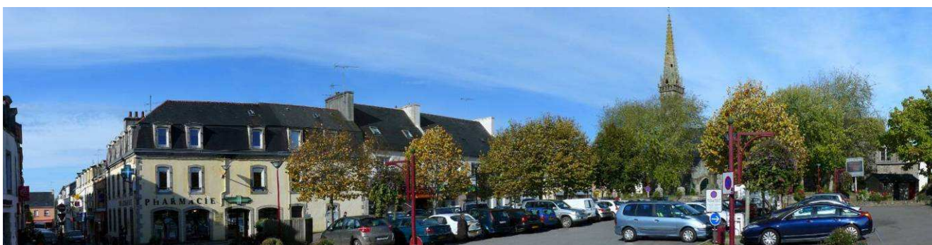
La place de l'église, une ouverture dans un tissu urbain dense. L'espace est polyvalent (marché temporaire et stationnement).
