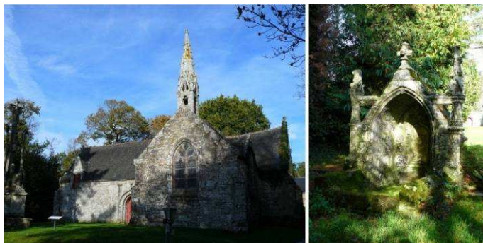
La chapelle St-Vennec et sa fontaine de granit
