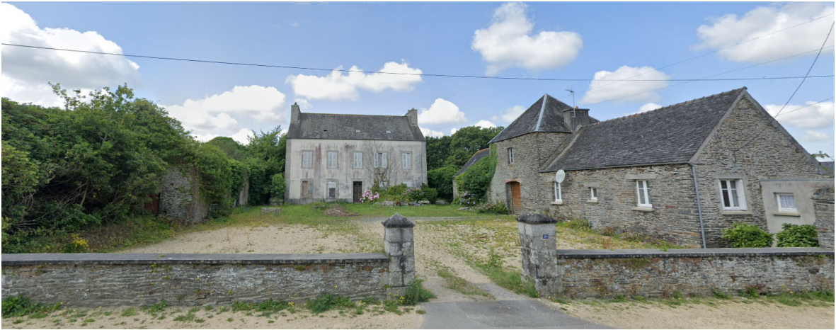
Longère, maison Le Pors et maison en location
