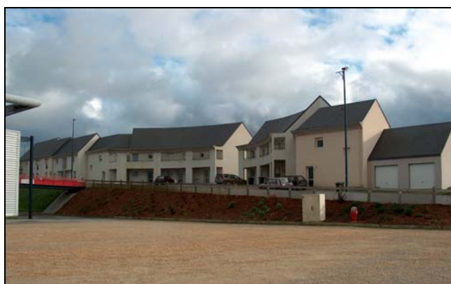
Logements HLM rue du Pors
