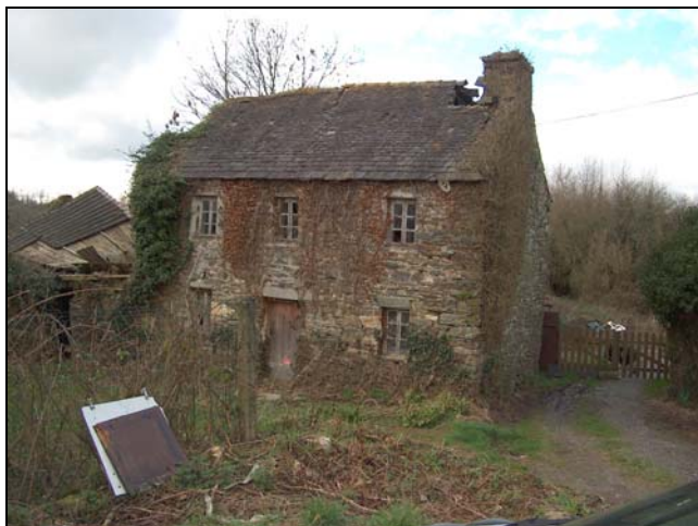
Bâtiment à rénover classé en Ar, à Kerroc'h
