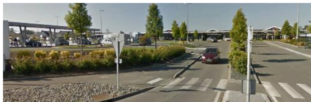
Zone d'activité commerciale du secteur de Kernévez Source : Google Earth
