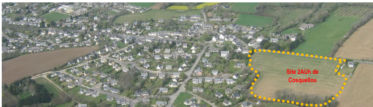
Photographie aérienne oblique de 2012 de la frange Est de l'agglomération du bourg
