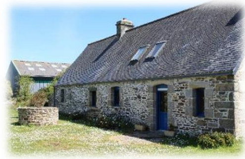
Maison située dans le secteur de Lanouris
