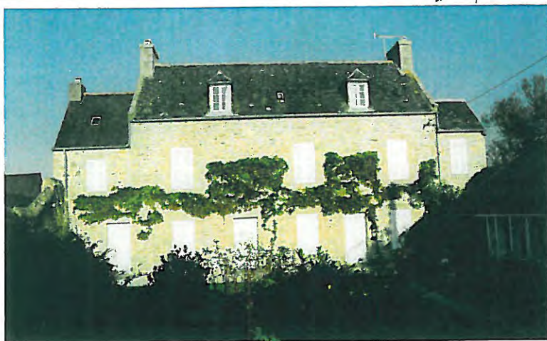
n° 1 rue Olivier HENRY Bâtiment d'intérêt architectural
