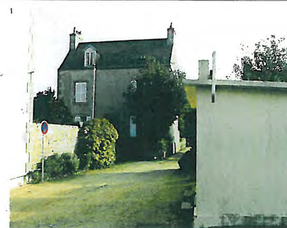
n° 27 Bâtiment d'accompagnement
