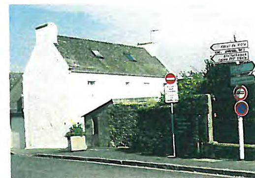
n° 55 Bâtiment d'accompagnement
