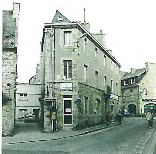
n° 2 Bâtiment d'accompagnement
