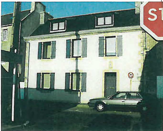
n° 19 Bâtiment d'accompagnement
