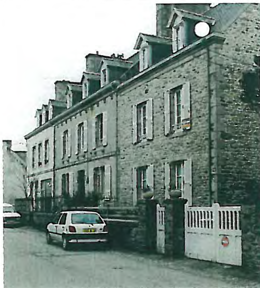
n° 26 Bâtiment d'accompagnement partie d'un ensemble des façades homogènes du n° 26 au n° 30
