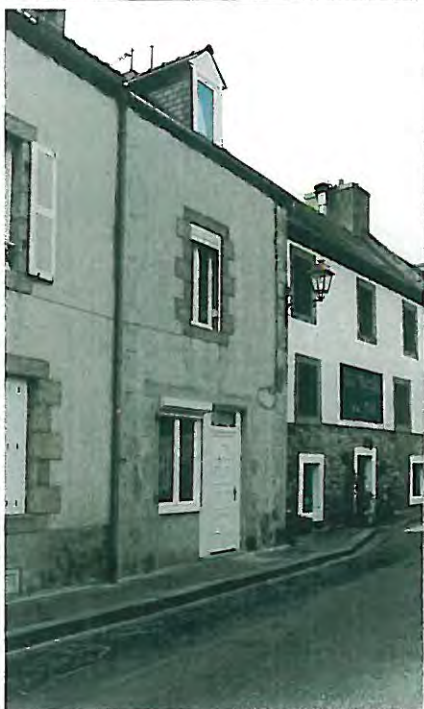
n° 11 Bâtiment d'accompagnement forme une séquence de façades homogènes avec le n° 9
