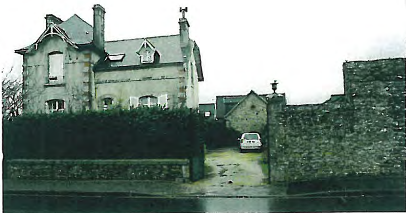
n° 11 Bâtiment d'intérêt architectural rue Laënnec
