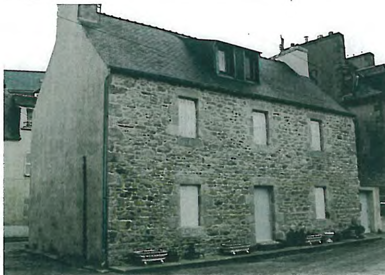
n° 6 Bâtiment d'accompagnement
