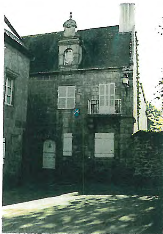
façade rue A. Rousseau
