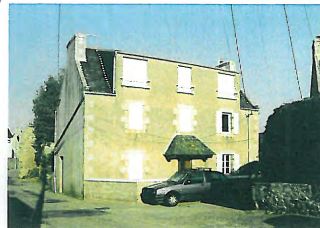
n° 14-16 Bâtiment d'accompagnement
