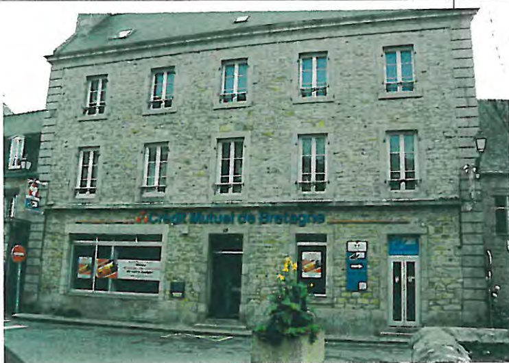
n° 10 Bâtiment d'accompagnement
