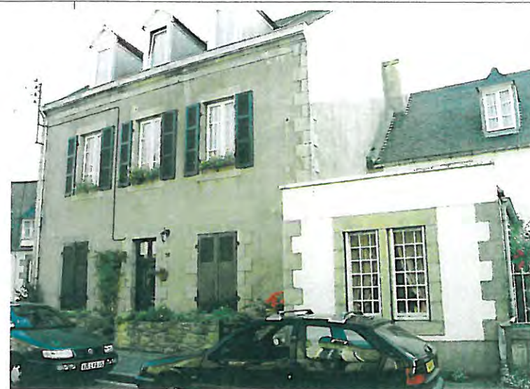
n° 28 Bâtiment d'accompagnement
