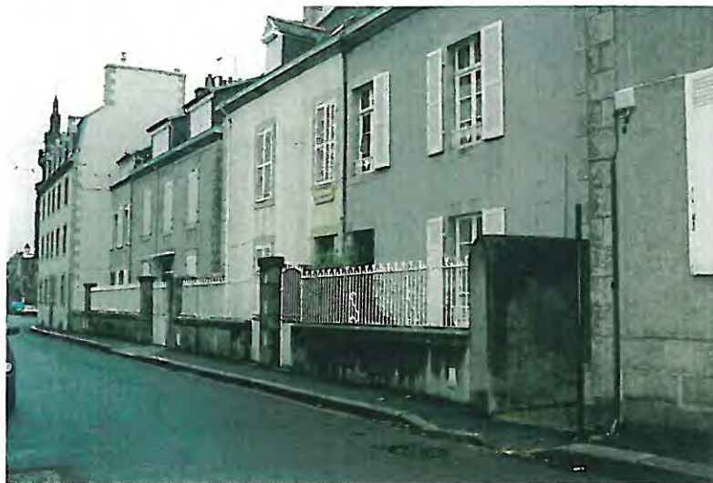
n° 11 Bâtiment d'accompagnement
