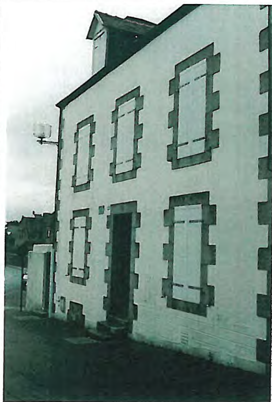
n° 38 Bâtiment d'accompagnement
