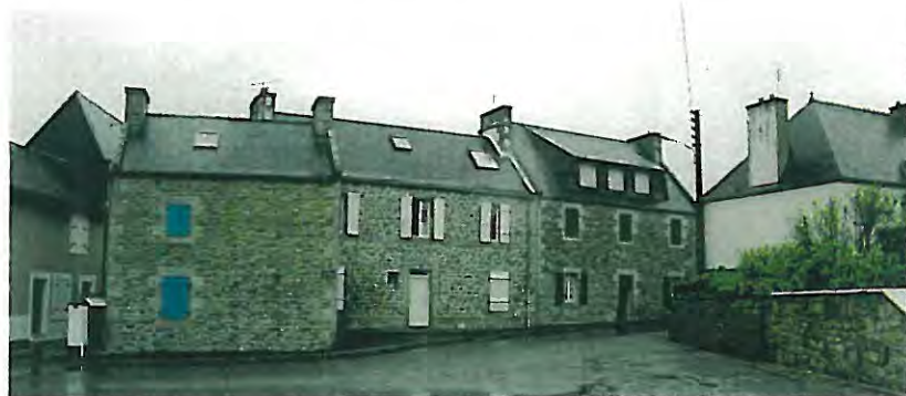
n° 15 Bâtiment d'accompagnement rue Ropartz Morvan
