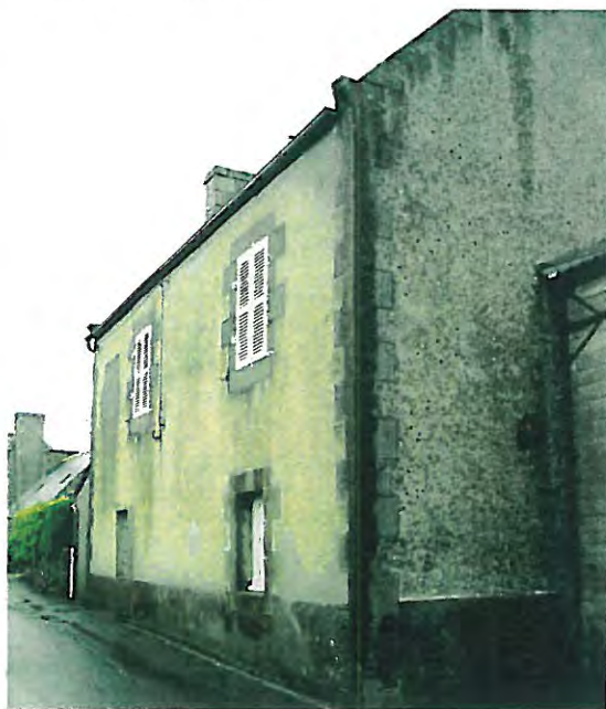
n° 6 Bâtiment d'accompagnement rue Joseph Le Mat
