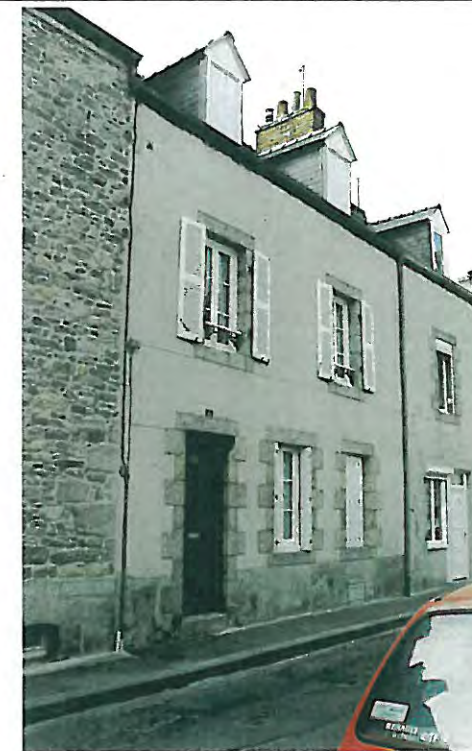
n° 9 Bâtiment d'accompagnement forme une séquence de façades homogènes avec le n° 11
