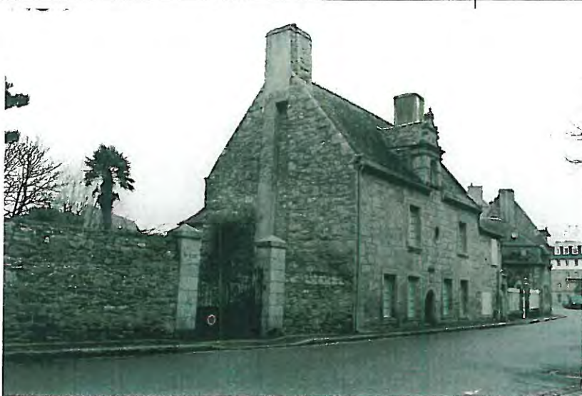
n° 18 Bâtiment inscrit I.S.M.H 06 Novembre 1997
