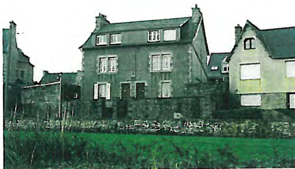
n° 8 - 10 Bâtiment d'accompagnement
