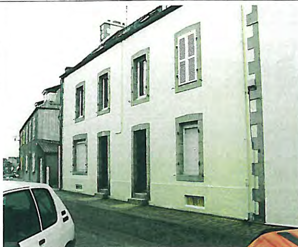
n° 13-15 Bâtiment d'accompagnement forme une séquence de façades homogènes avec le n°17
