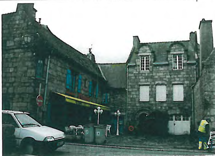
n° 24 Bâtiment d'accompagnement
