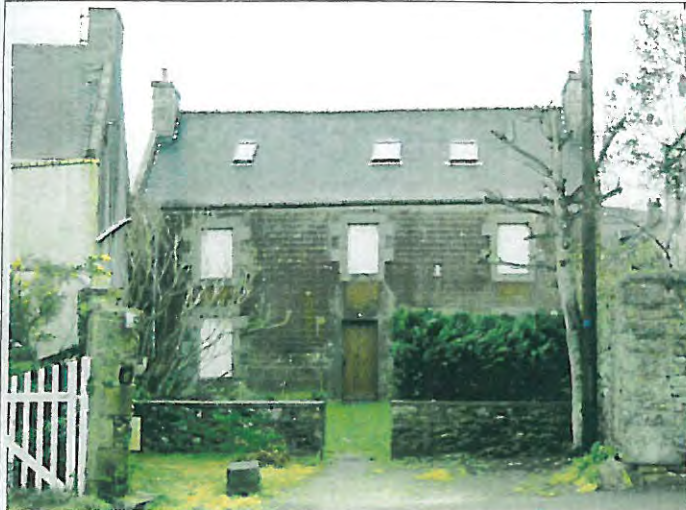
n° 4 Bâtiment d'accompagnement
