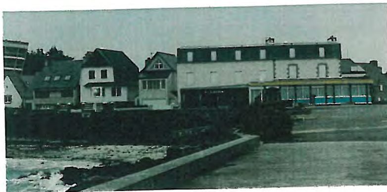
parcelle n° 128 Bâtiment non répertorié
