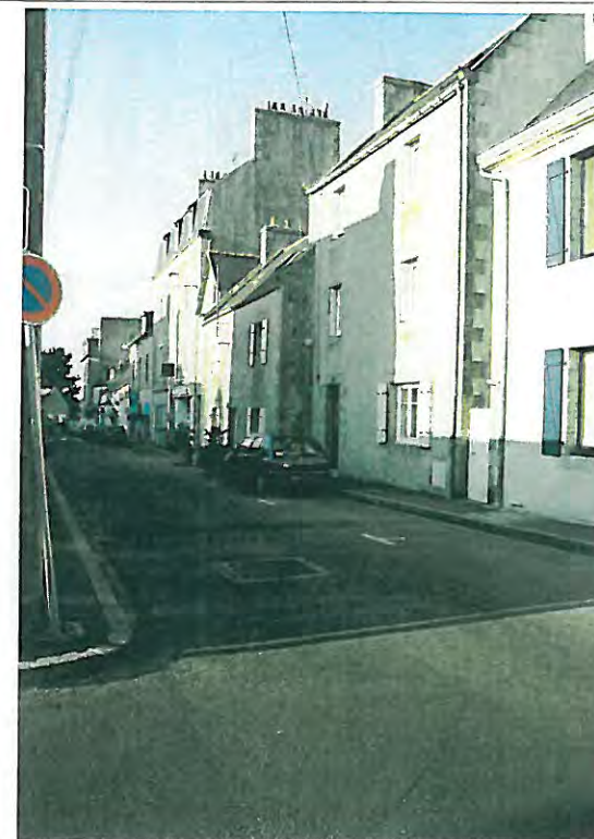
n° 15 Bâtiment d'accompagnement
