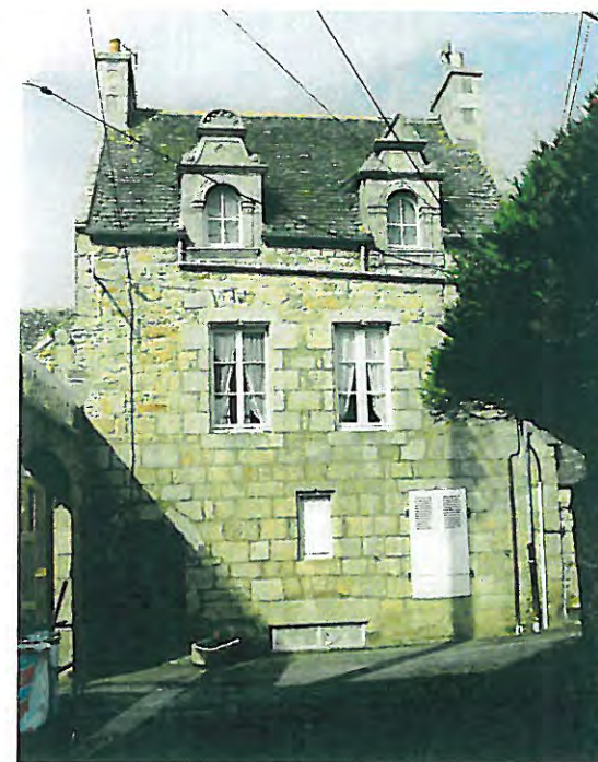
n° 12 Bâtiment d'accompagnement rue Yan d'Argent
