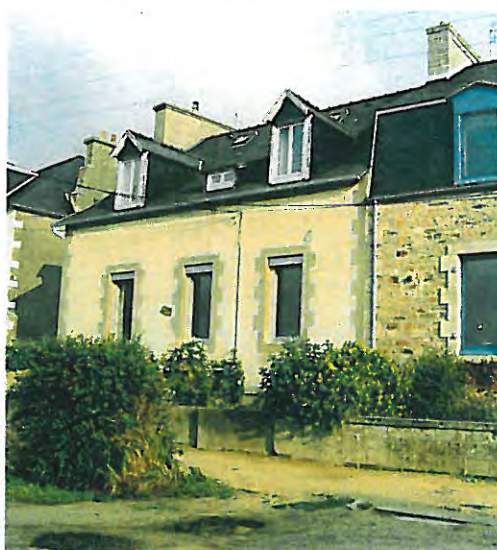
n° 10 Bâtiment d'accompagnement
