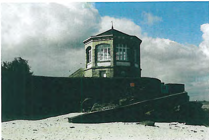
Pavillon et murs de clôture côté mer Bâtiment et ensemble d'intérêt architectural
