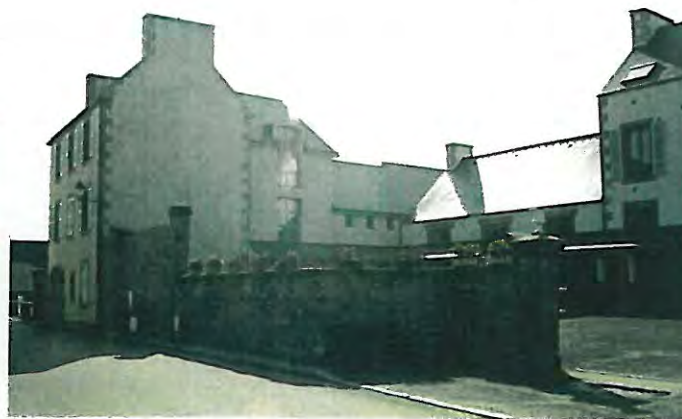
n° 80 Bâtiment d'accompagnement (bâtiment sur rue)
