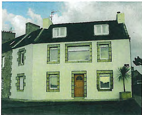
n° 2 Bâtiment d'accompagnement
