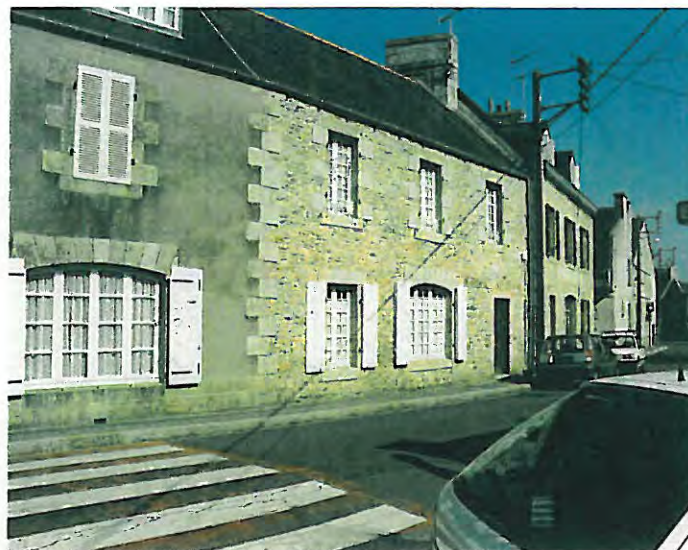
n° 16 Bâtiment d'accompagnement
