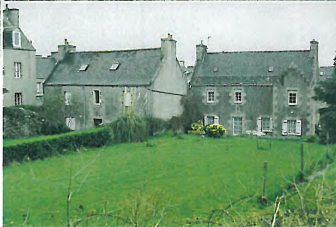
n° 6 Bâtiment d'accompagnement ( bâtiment situé au sud-ouest de la parcelle 98 en fond de cour )
