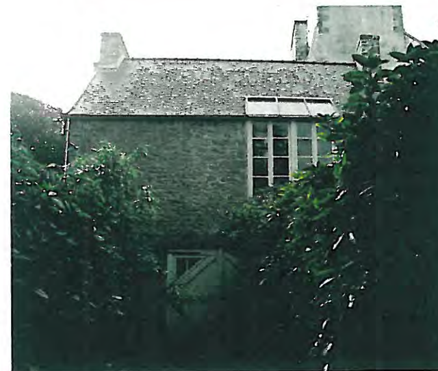
parcelle n° 633 Bâtiment non répertorié
