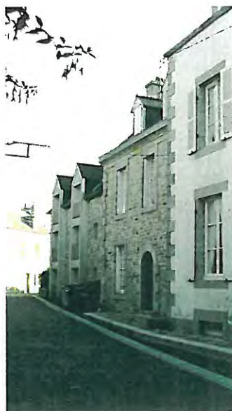
n° 20 Bâtiment d'accompagnement rue Yan d'Argent
