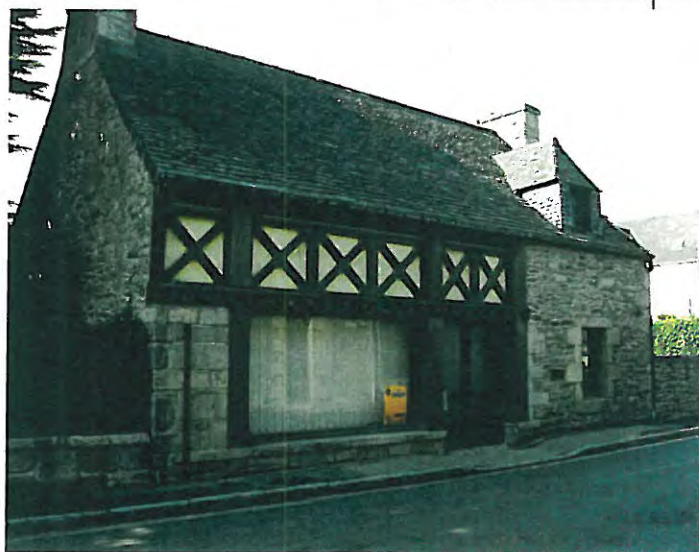
n° 90 bis Bâtiment d'accompagnement parcelle n° 233
