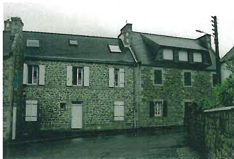
n° 17 Bâtiment d'accompagnement rue Ropartz Morvan
