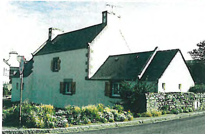
n° 63 Bâtiment d'accompagnement (pour la maison et son annexe)
