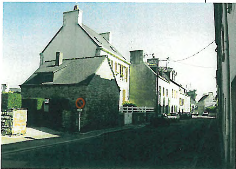
n° 26 Bâtiment d'accompagnement
