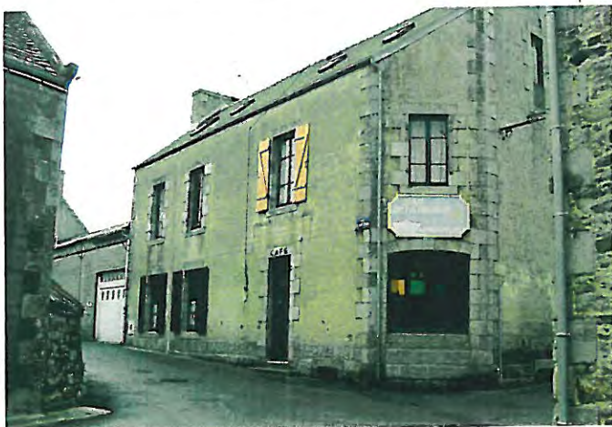
n° 2 Bâtiment d'accompagnement rue Joseph Le Mat
