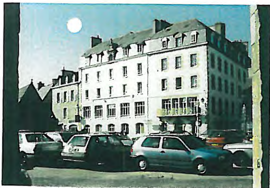
n° 2 Bâtiment d'accompagnement
