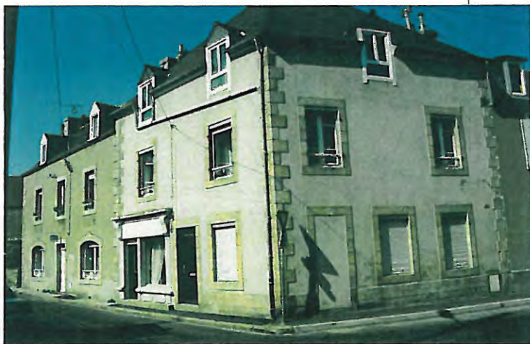
n° 2 Bâtiment d'accompagnement
