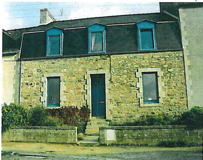
n° 8 Bâtiment d'accompagnement
