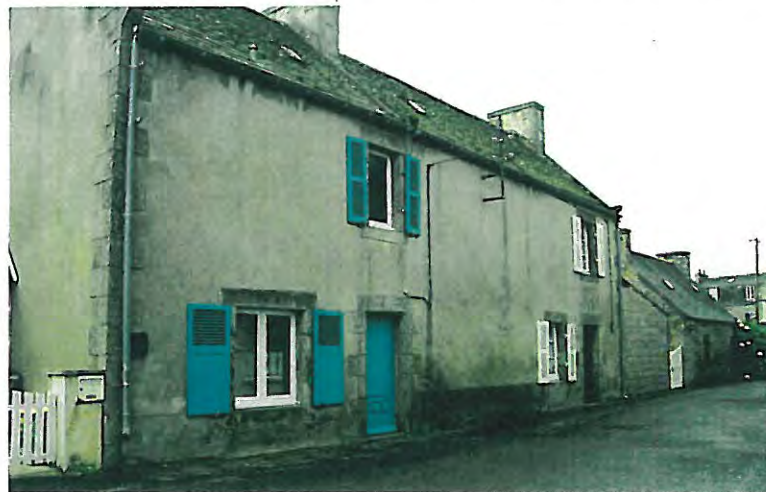
n° 10 Bâtiment d'accompagnement rue Joseph Le Mat
