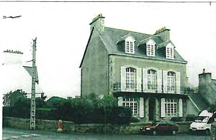
n° 4 Bâtiment d'accompagnement
