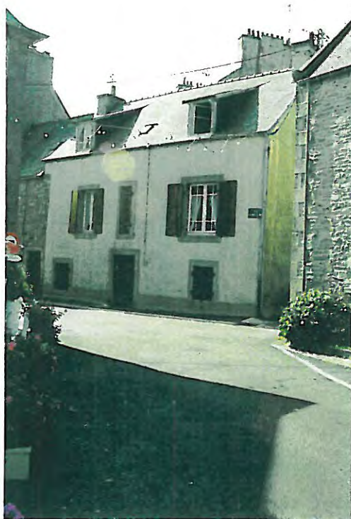
n° 2 Bâtiment non répertorié rue Esprit Le Mat
