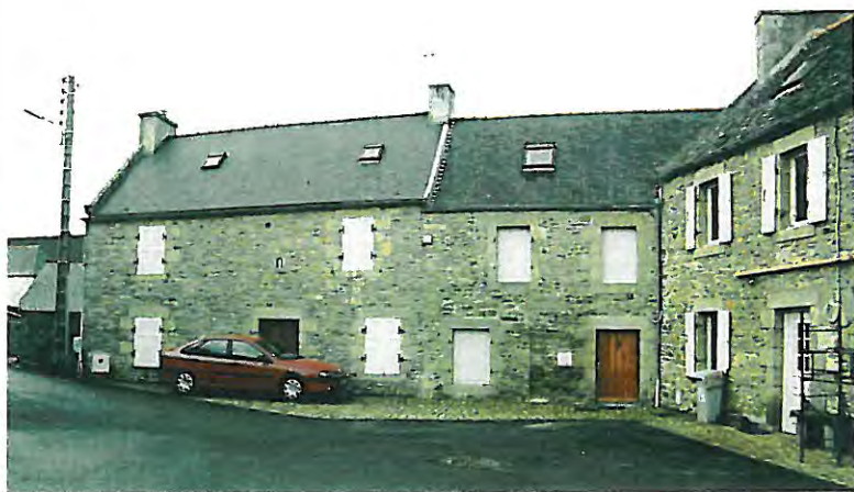
n° 3 Bâtiment d'intérêt architectural rue Kléber inclus dans une séquence homogène de façades avec le numéro 5
