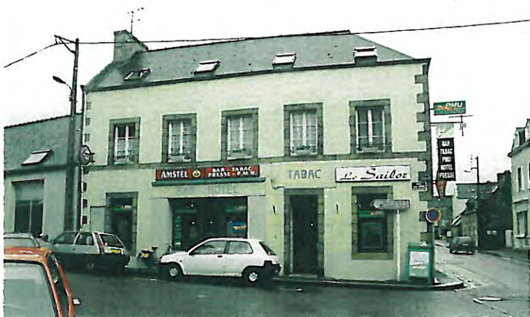
n° 2 Bâtiment d'accompagnement rue Ropartz Morvan
