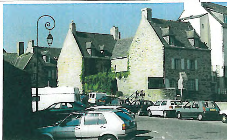
n° 19 Bâtiment inscrit I.S.M.H 04 février 1974
