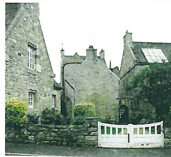
n° 10 Bâtiment d'accompagnement rue Yan d'Argent
