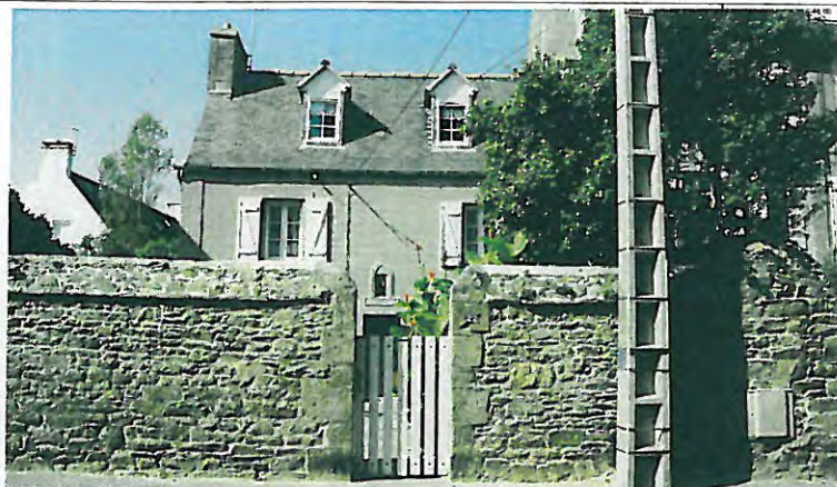
n° 22 Bâtiment d'accompagnement
