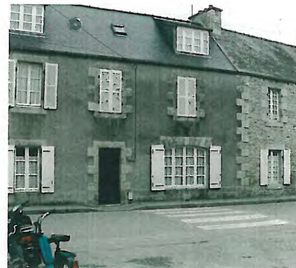
n° 18 Bâtiment d'accompagnement
