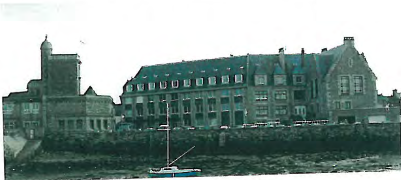
n° 2 Bâtiment d'accompagnement Place G. Tessier
