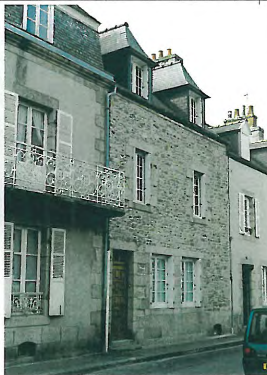
n° 7 Bâtiment d'accompagnement
