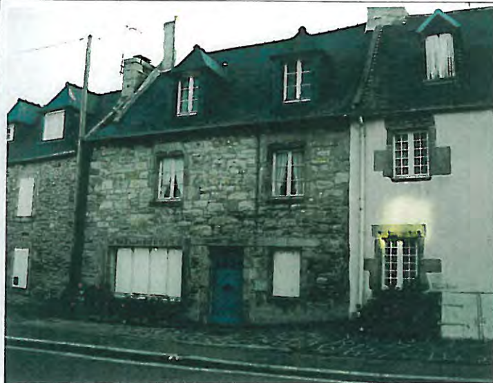
n° 42 Bâtiment d'accompagnement
