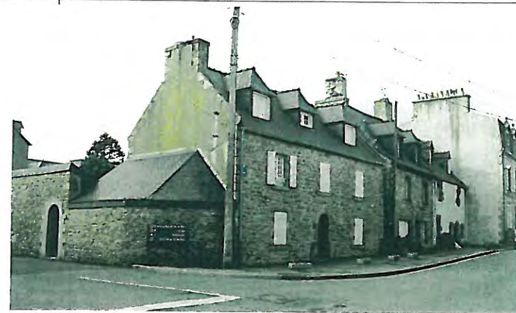
n° 44 Bâtiment d'accompagnement
