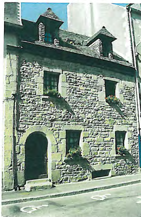
n° 20 Bâtiment d'accompagnement
