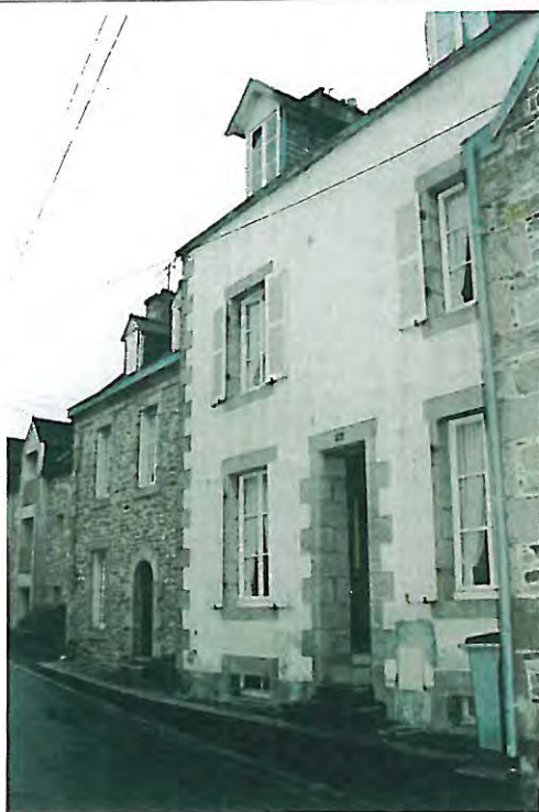
n° 18 Bâtiment d'accompagnement rue Yan d'Argent
