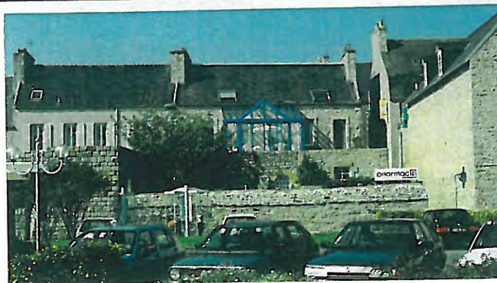
parcelle n° 559 Bâtiment non répertorié arrière du n° 15 de la rue Gambetta
