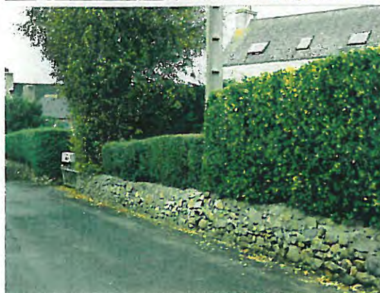
Parcelle 242 : mur de clôture
