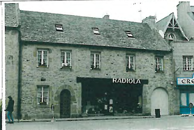
n° 11 Bâtiment d'accompagnement
