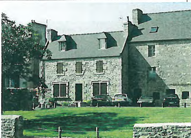
n° 8 Bâtiment d'intérêt architectural Place de la République
