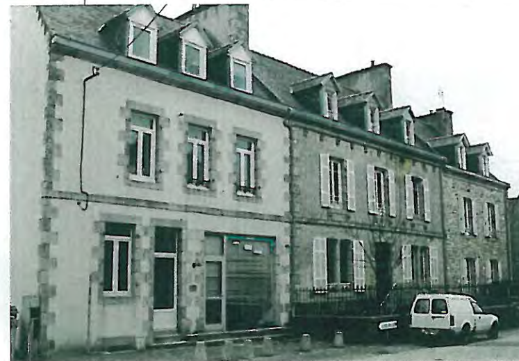
n° 30 Bâtiment d'accompagnement
