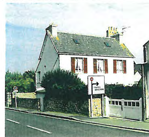
n° 41 Bâtiment d'accompagnement Partie sud du bâtiment seulement
