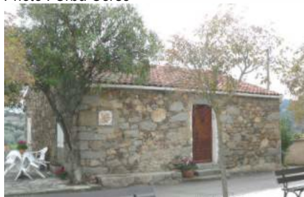
Ancien presbytère. Photo : Mérimée
