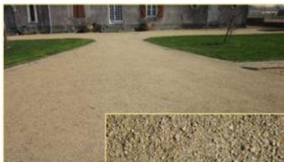
Stabilisé mécaniquement « CHAPE »
