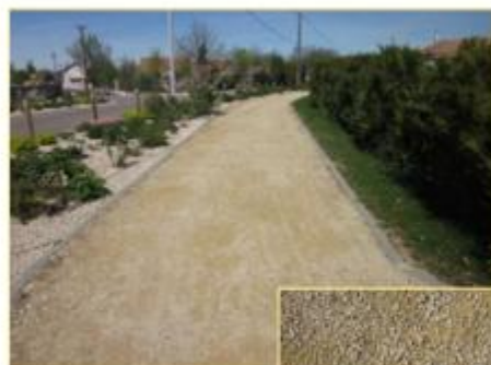
Stabilisé mécaniquement « STABILISÉ CALCAIRE »
