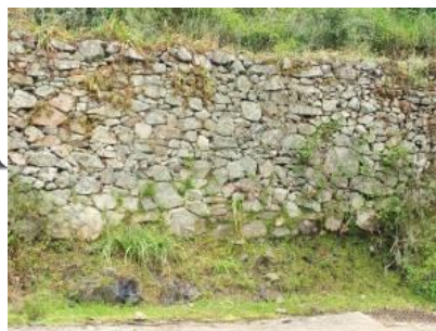
Exemple de murs de soutènement
