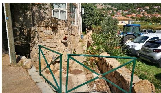
Pluvial à proximité de la mairie
