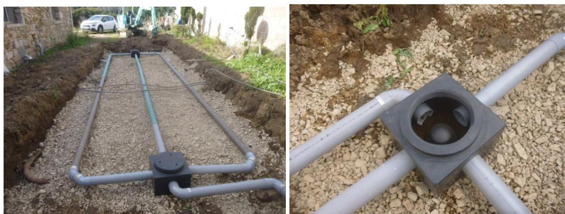
Illustrations de travaux d'une installation neuve
