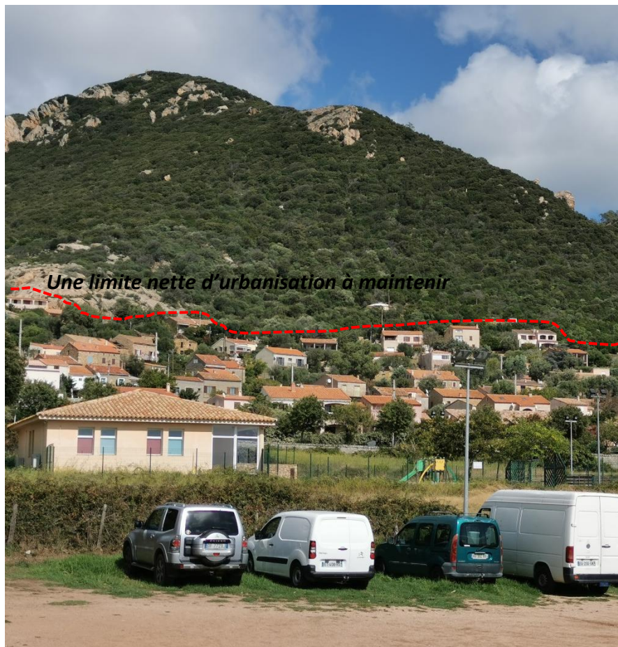
Un grignotage du massif naturel par les nouvelles constructions
