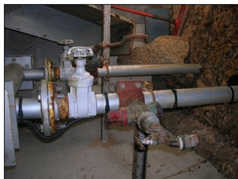
Photographie 36 - Intérieur de l'ancien bâtiment renfermant l'unité de traitement
