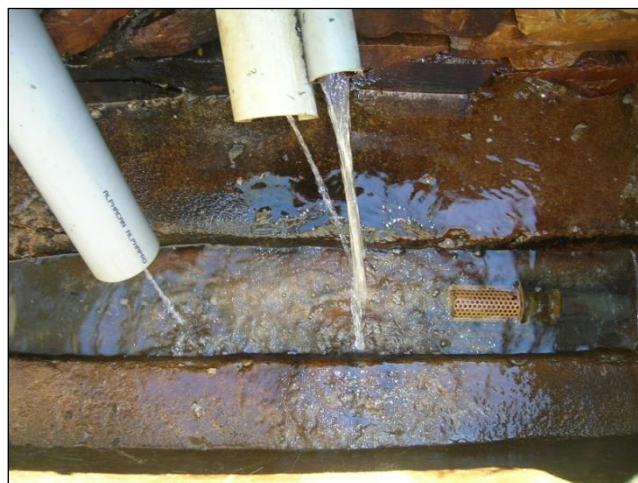
Photographie 3 - Vue intérieure de l'ouvrage de collecte
