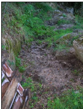
Photographie 4 - Zone de drain
