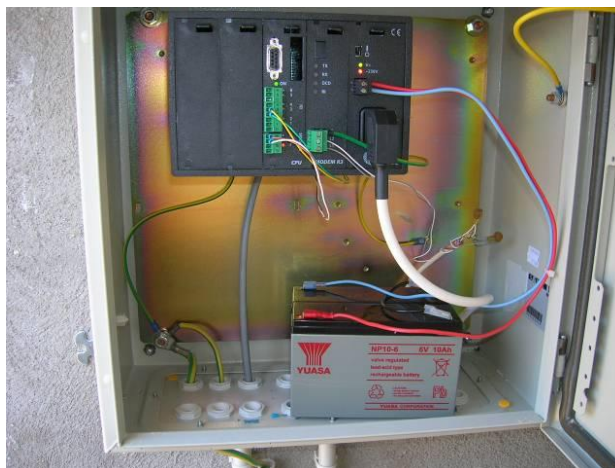
Photographie 46 - Télésurveillance SOFREL (GIANNUCCIO)
