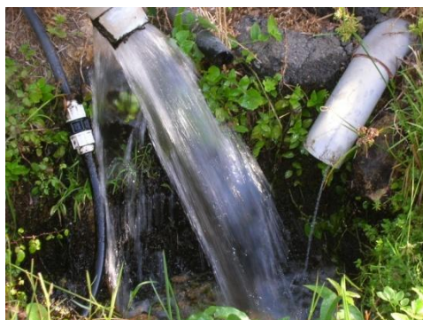
Photographie 32 - Trop plein à droite, vidange à gauche
