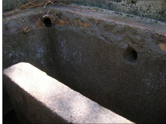
Photographie 16 - Détail du trop plein et de l'arrivée supplémentaire
