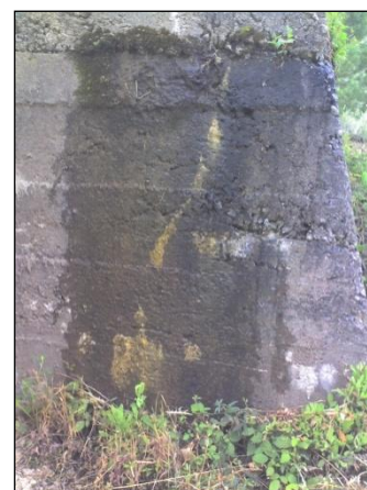
Photographie 37 - Aspect du génie civil
