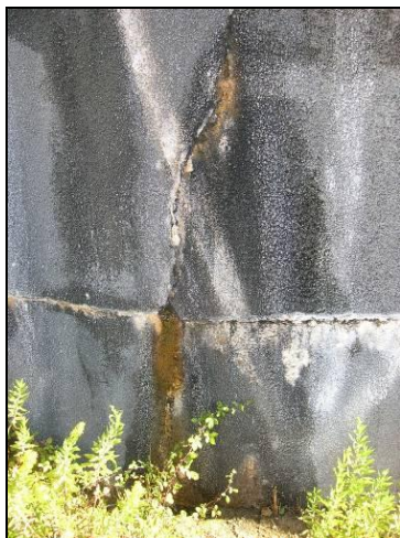
Photographie 21 - Face sud
