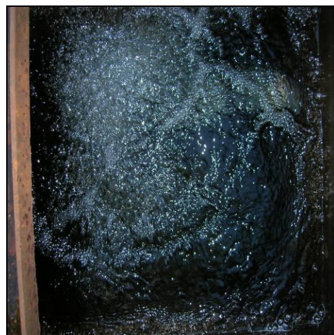
Photographie 11 - Vue intérieure du brise-charge (en charge)
