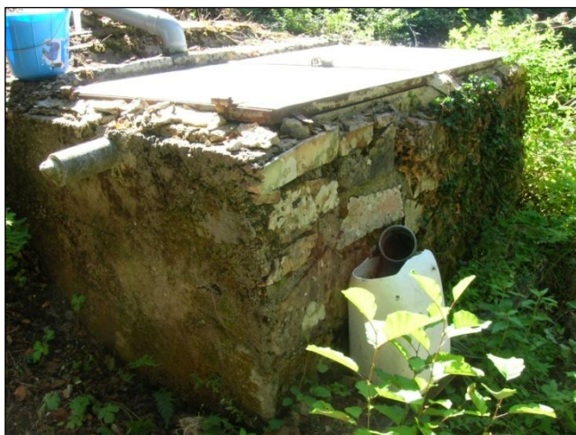
Photographie 2 - Vue extérieure de l'ouvrage de collecte
