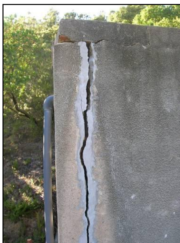
Photographie 10 - Aperçu du génie civil
