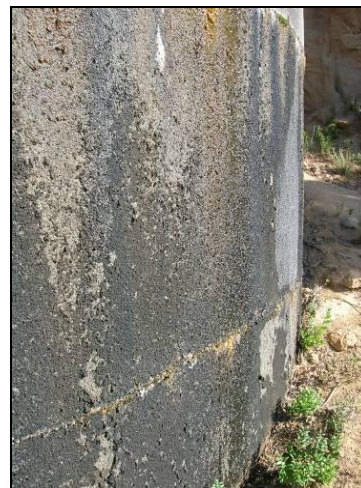
Photographie 23 - Face nord-est
