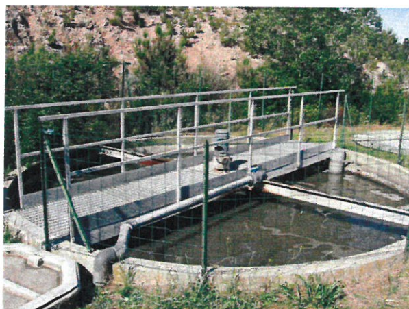
Vue générale du bassin d'aération
