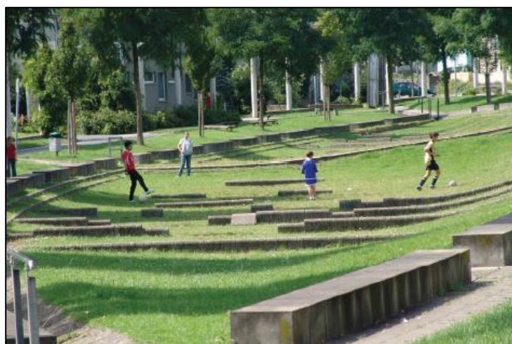
Bassin d'infiltration paysager
