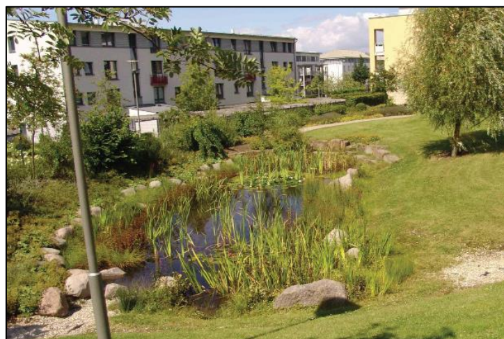
Bassin de rétention en eau
