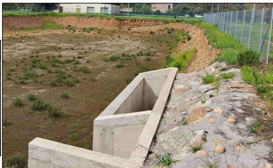
Bassin de rétention
