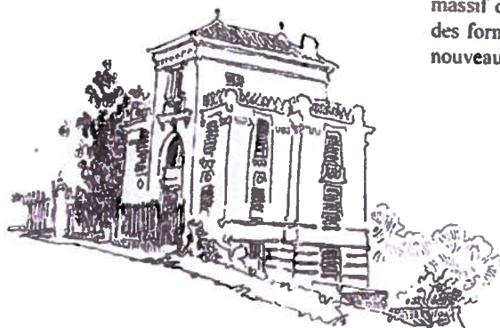
Toiture à croupes sur avant-corps central toits terrasses sur les ailes - Sainte Marie Sicché
