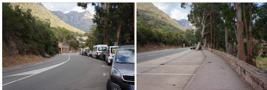
Stationnements et trottoir
