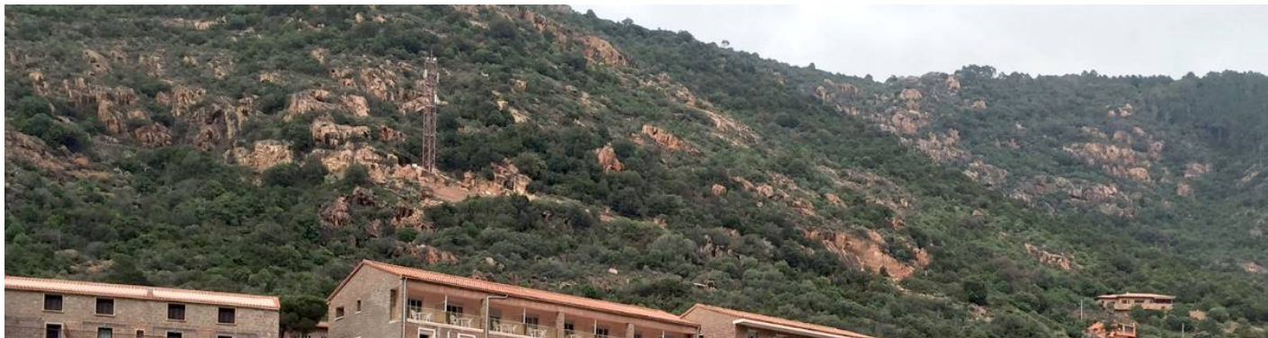
Porto – vue sur les parois instables
