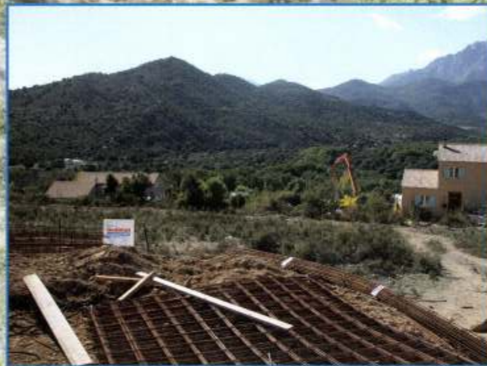
Hameau de Candela - Constructions en cours
