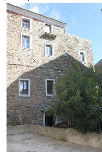
La prédominance des murs dans le paysage renforce l'aspect homogène et massif des ensembles bâtis. Il est exceptionnel d'observer les traditionnels linteaux (en bois ou monolithe) ou arcs en pierres appareillées surmontant les baies. Les appuis de fenêtres ont quant à eux peu ou pas débordants.
