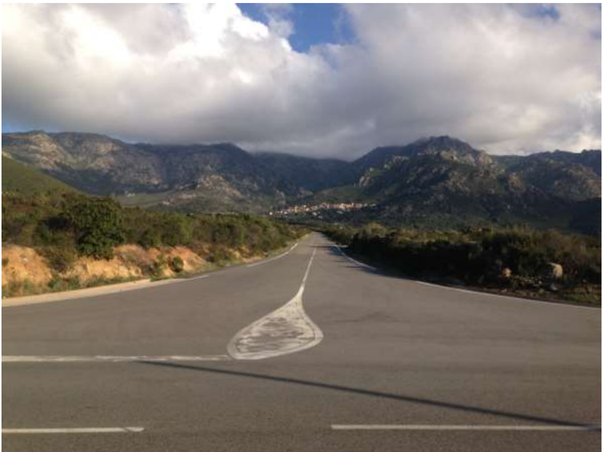
Croisement de la Balanina avec la route du village d'Urtaca : signalétique minimale et peu de sécurité au croisement : marquage d'un stop obligeant à l'arrêt total du véhicule et participant à un conflit de vitesse avec celle de transit de la Balanina.
