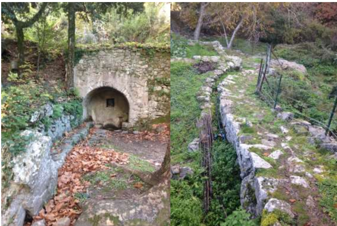
Canalisation de l'eau pour les jardins en terrasses de l'Ortu et fontaine à la sortie du village.
