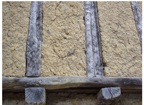
Paroi à pans de bois et remplissage en torchis (on distingue les éléments de paille mélés au liant)
