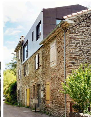
Extension contemporaine traitée avec des tôles métalliques pleines laissées brutes et stabilisées par une solution compatible avec une toiture d'une maison cévenole, Yann Roubeau architecte
