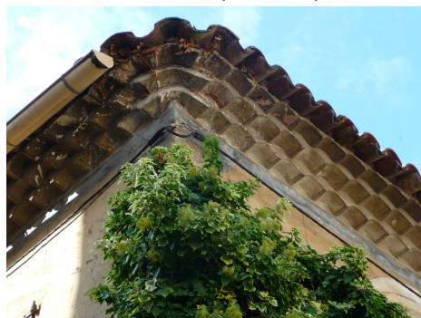
Génoise traditionnelle à 3 rangs de tuiles
