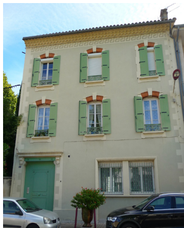
Façade début XXe, encadrements de baies en appareil mixte pierre et briques rouges
