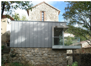
Extension de maison, TAUTEM Architectes, assurant à la fois la peau des façades et la couverture, le bac-acier bloquant l'oxydation, pour une architecture contemporaine de qualité
