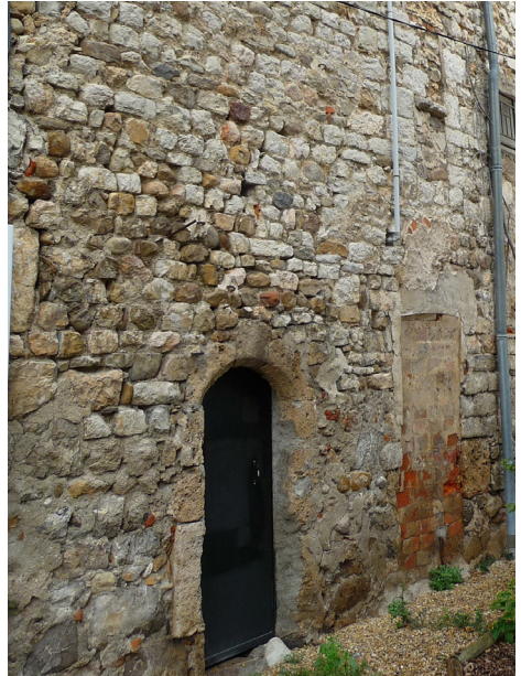
Appareil de tout-venant et de moëllons dégrossis
