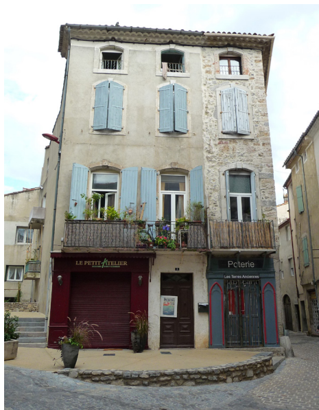
1 même bâtiment d'origine : on regrette le traitement différencié de la façade !
