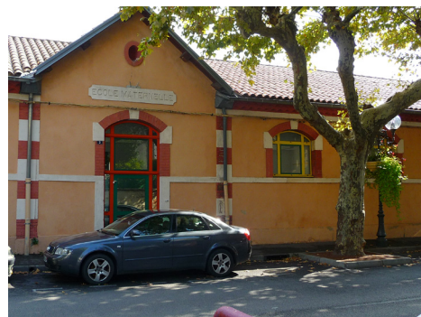
Débord de couverture sur pignon dont les chevrons sont protégés par un lambrequin
