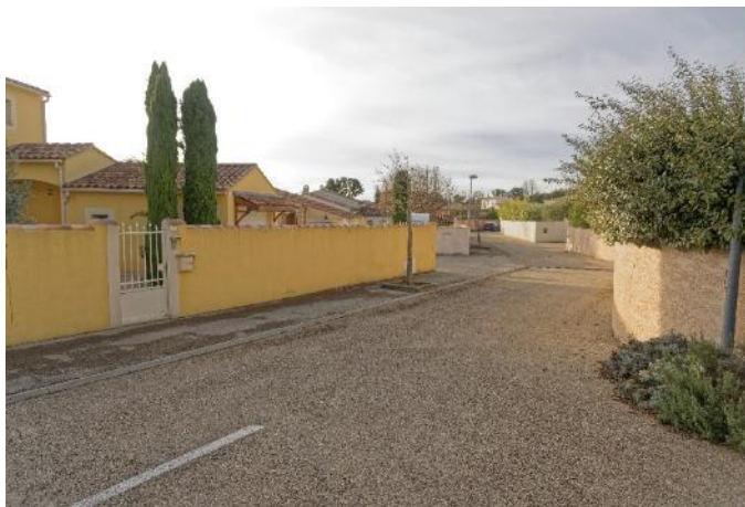
Traitement adapté de la voirie (Photo ASE – Janvier 2023)
