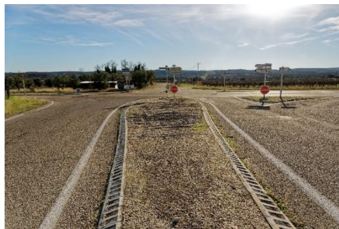
Croisement RD 3B et RD 981 au niveau de la pépinière (Photo ASE – Janvier 2023)
