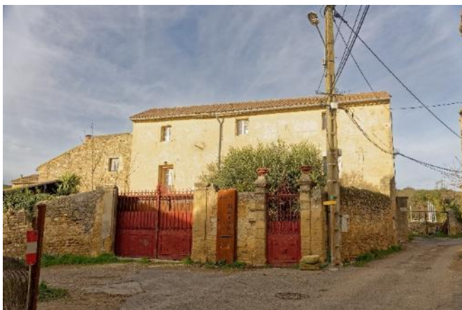
Ancienne bâtisse agricole (Photo ASE – Janvier 2023)
