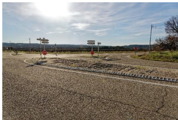
Croisement entre la RD 981 et la RD 3 (Photo ASE – Janvier 2023)
