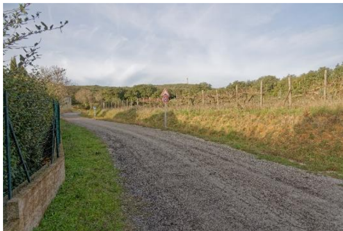
Route non revêtue (Photo ASE – Janvier 2023)
