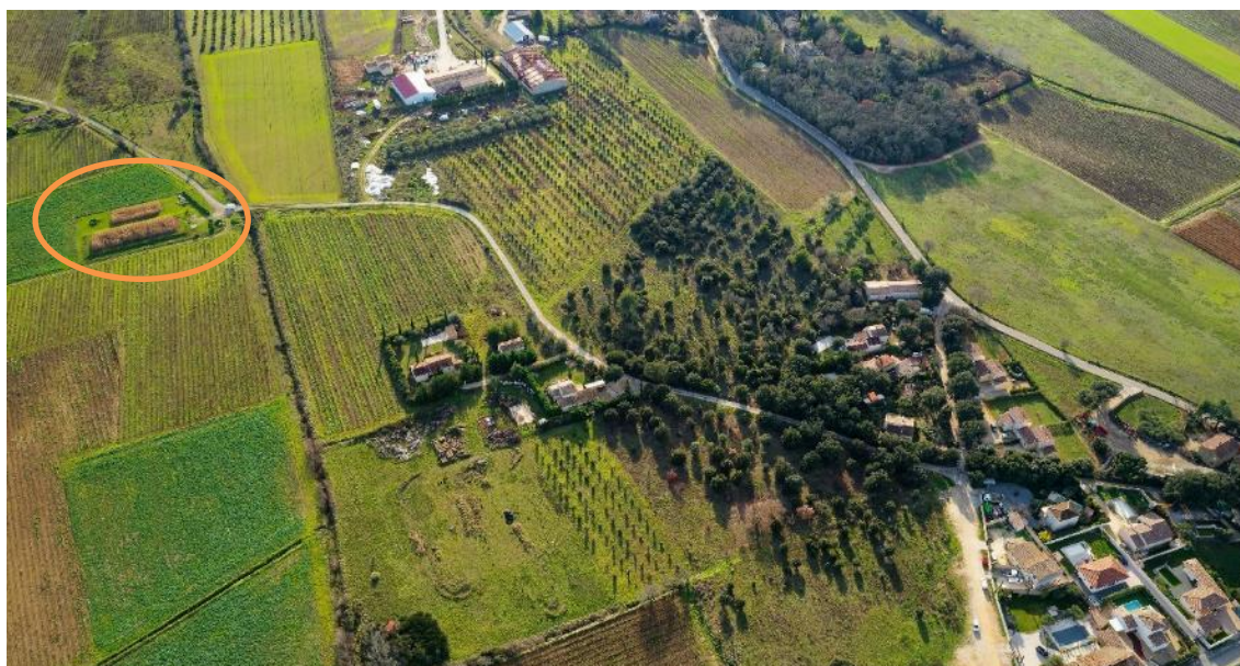
Figure 4 : Localisation de la STEP d'Argilliers (Drone ASE – Janvier 2023)
