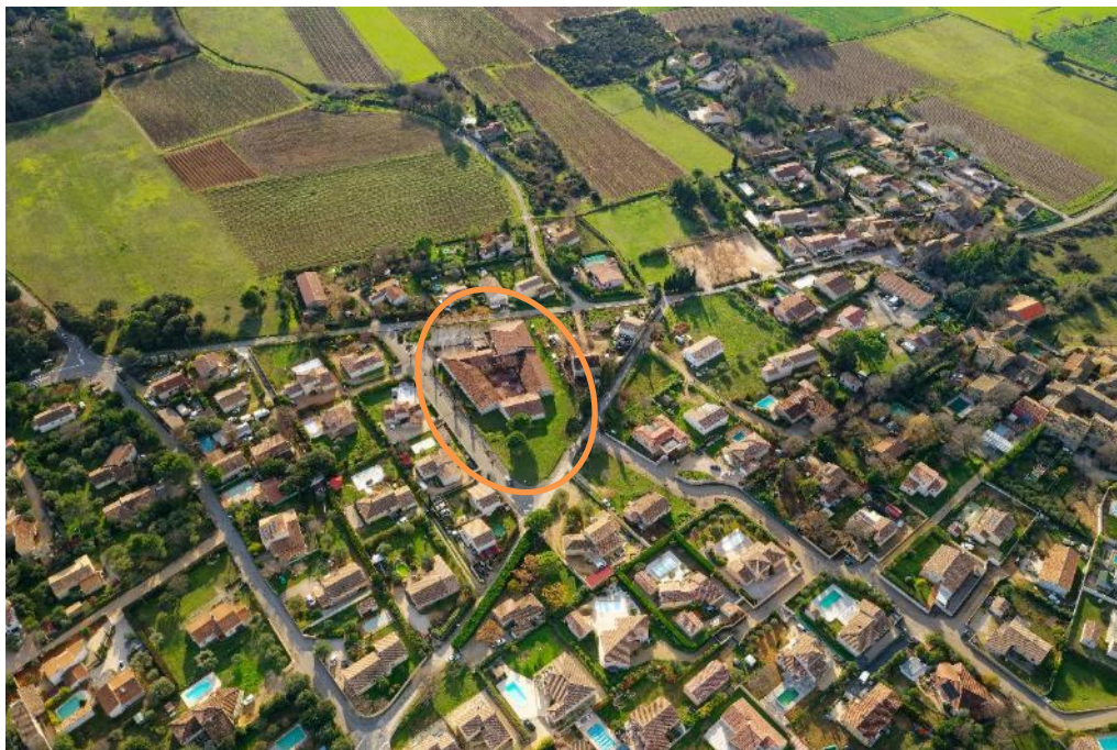
Localisation de l'école élémentaire (Drone ASE – Janvier 2023)
