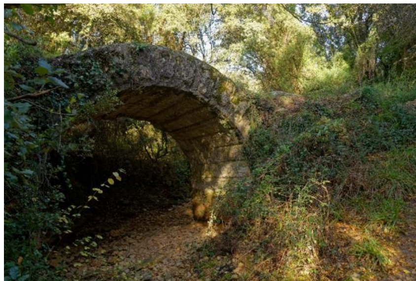
Pont de Bornègre (Photo ASE – Janvier 2023)
