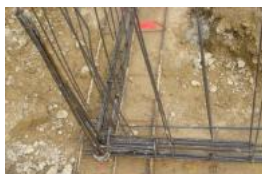
Nœud de chaînage - Continuité mécanique
