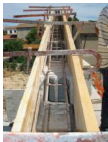
Mise en place d'un chaînage au niveau du rampart d'un bâtiment
