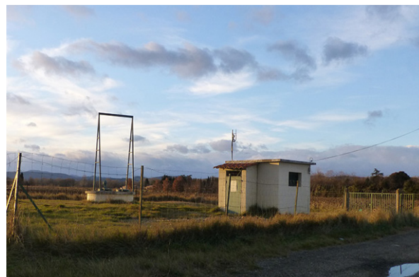
Captage de Cardet
