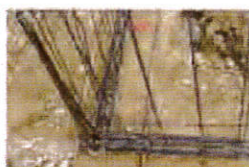
Nœud de chaînage - Continuité mécanique
