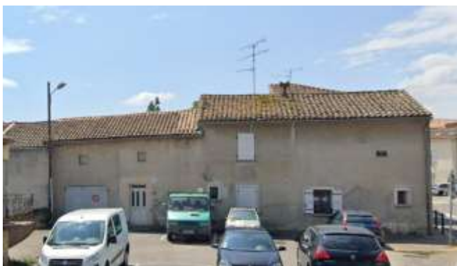
Toiture ancienne - source : IATE
