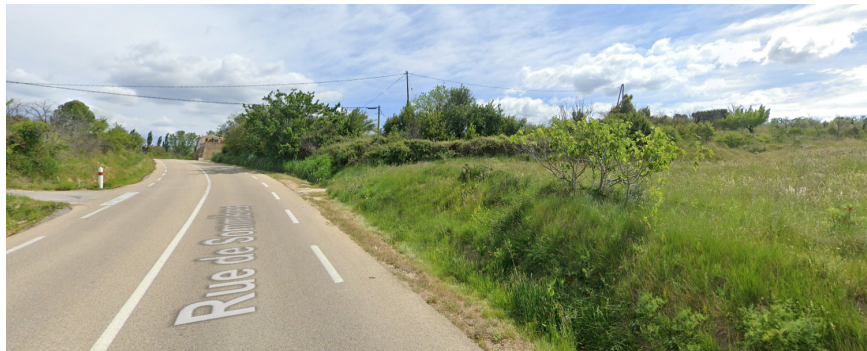
Vue de l'extension « Est » par le sud (RD22)
