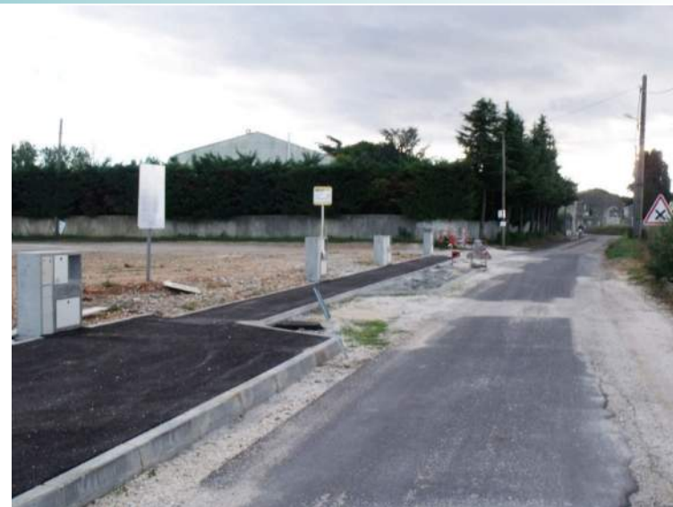
Arrêt de bus au niveau de la ZAC du Grès
