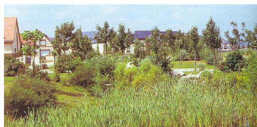
Principe de bassin de rétention utilisé comme parc public.
