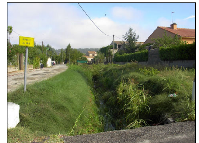
L'axe de drainage d'un des petits ruisseaux qui traversent les lotissements au sud de Clarensac
