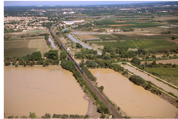
Voie SNCF et Canal BRL à Gallargues-le-Montueux pendant la crue de 2002. Source : Mr Blot
