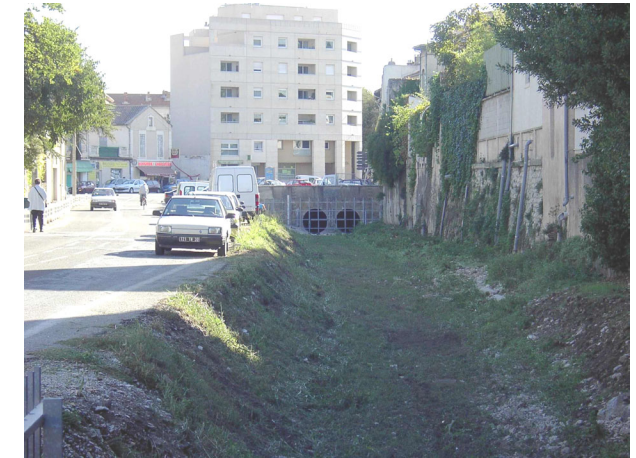
Entrée en souterrain du cadereau d'Alès
