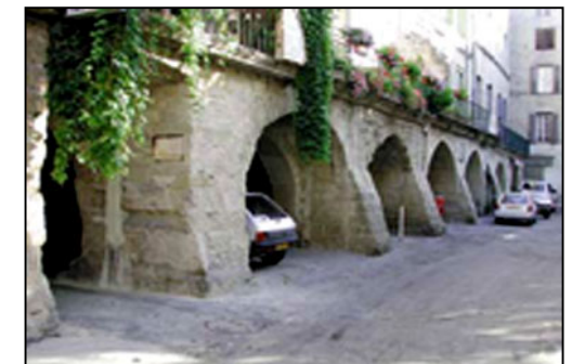
Les arches du Pont Romain dans la vieille ville
