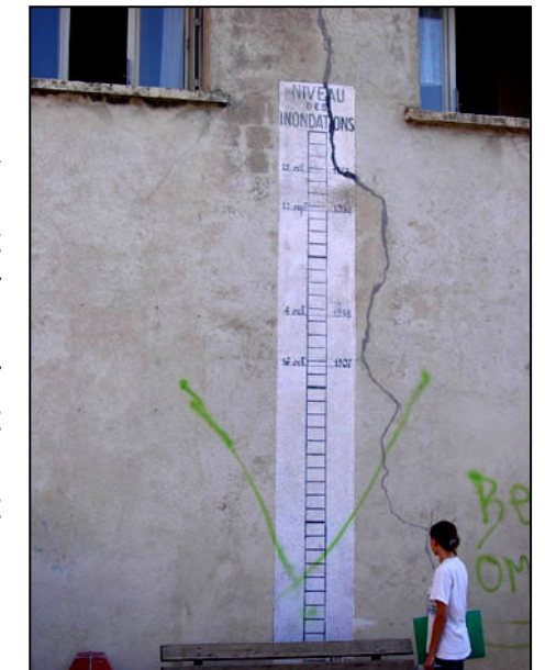
L'échelle de crue de Quissac
