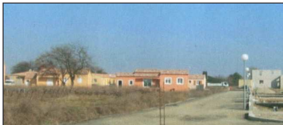
Lotissement en construction
