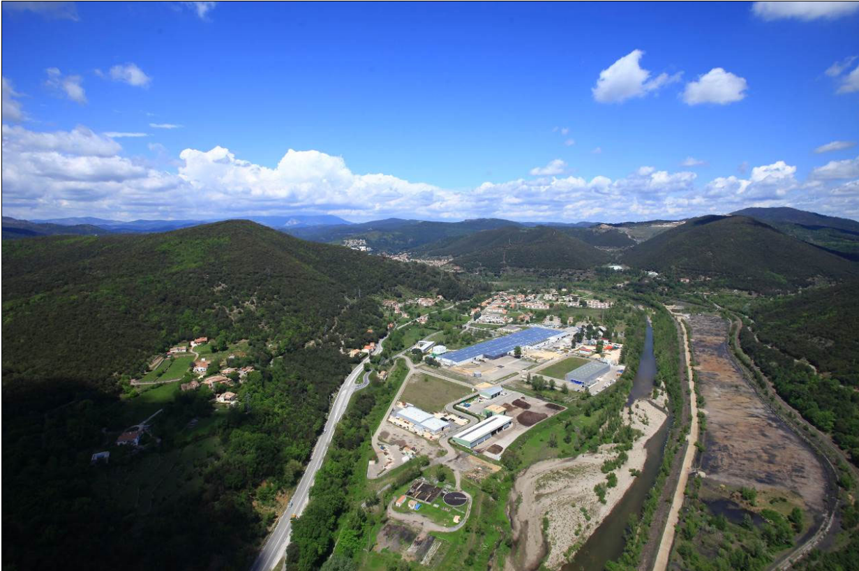
Figure 3. Vue aérienne sur la partie sud du quartier : la ZAC (© Entre Ciel Terre et Mer)
