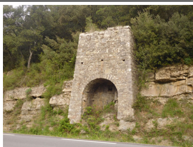
48. Élément minier, Lieudit Pourcayrargues, RN 106, E 790
