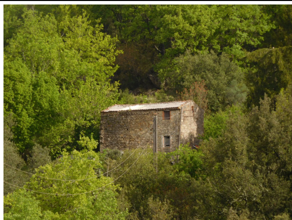
40. Lieudit Montredon, parcelle D 529
