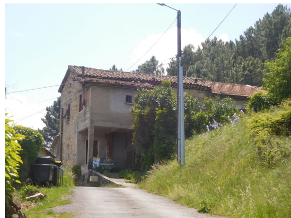
7. Lieudit Courbessac, parcelles A 1378 et 1517
