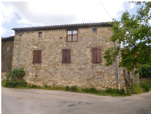
26. Lieudit Montredon, parcelle D 975
