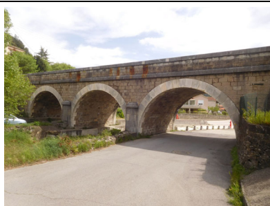
45. Pont sur le Gravelongue, RN 106
