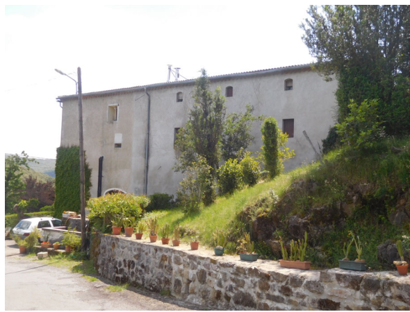
6. Lieudit Courbessac, parcelles A 1451, 1454 et 1455
