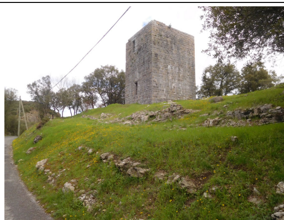
35. Tour carrée (Monument Historique), Lieudit Saint Etienne
