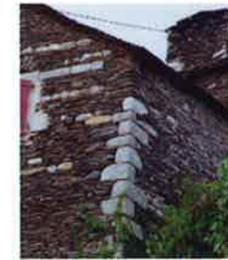
Pierre de taille pour les chaînages d'angle, briques pour faciliter l'alignement des tableaux, grès taillé pour l'ornementation des portes d'entrée
