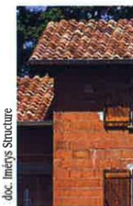
Murs en blocs de terre cuite à alvéoles verticales. Faciles à monter, ces murs offrent le confort d'une isolation répartie.
