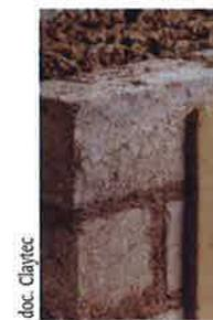
Mortier de terre-copeaux de bois, blocs de terre-paille maçonnés à l'argile, et panneau de finition en terre: le choix des matériaux naturels est vaste.
