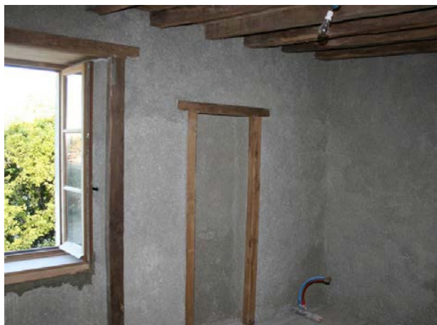
Doublage intérieur isolant en béton de chanvre et chaux, - brut, prêt à recevoir une finition - après enduit finition chaux - sable pigmenté
