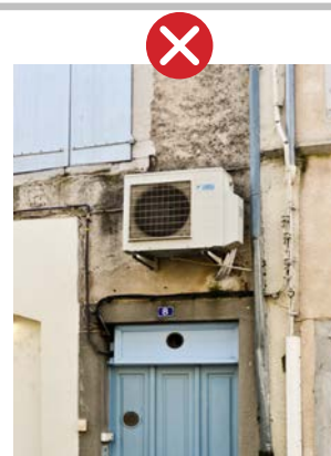
Contrexemple d'appareil de climatisation ou pompe à chaleur
