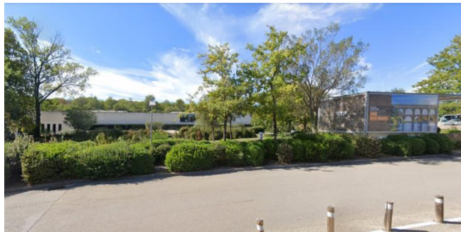
Musée du Pont-du-Gard
