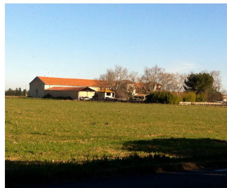
Vue sur le mas depuis la RD135
