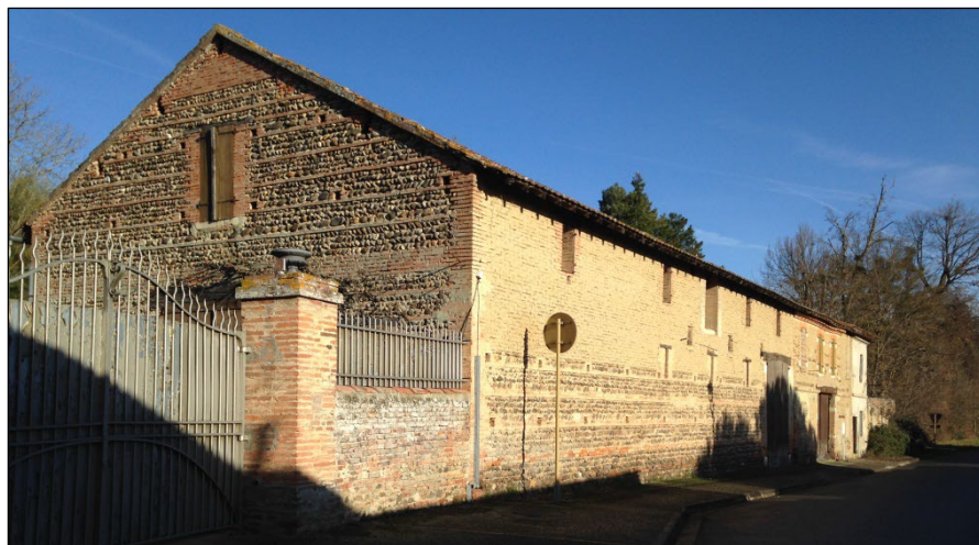
Appareillage en briques, galets et façade en argile crue
