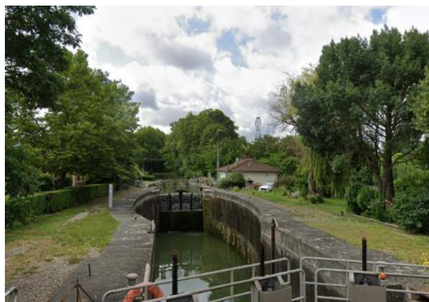
Le canal au niveau de l'écluse, privatisé à droite par une habitation implantée trop proche
