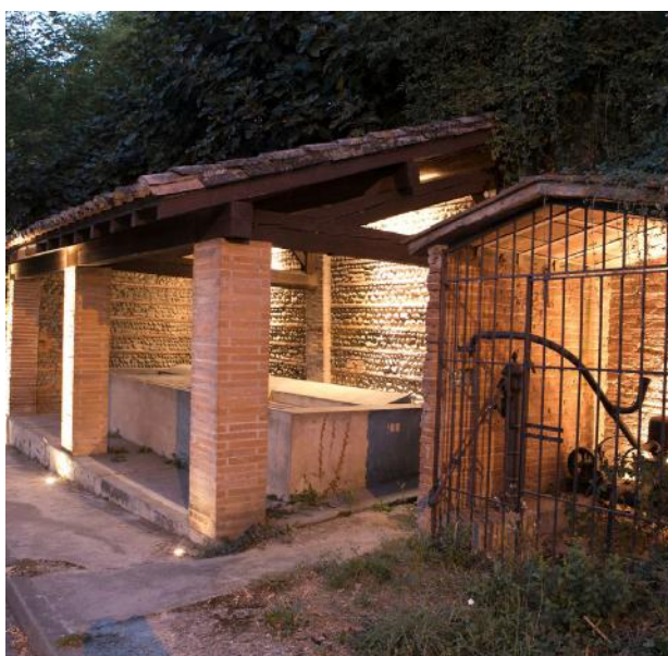
△ Le lavoir de Broc Site de la ville de Castanet-Tolosan
