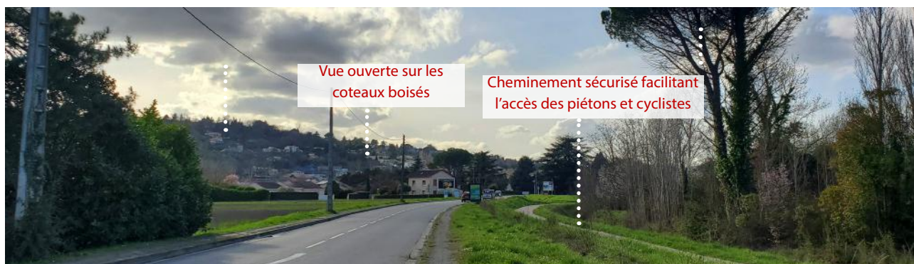
△ Vue sur les coteaux depuis l'avenue Barthélémy Salettes et Jean Marie Manset Cittanova
