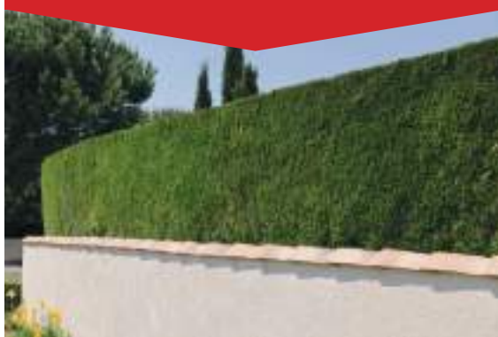
Muret sur toute la surface
