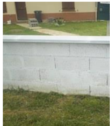
MUR DE CLOTURE NON ENDUIT
