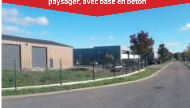
Clôture grillagée sans haie, sans aménagement paysager, avec base en béton
