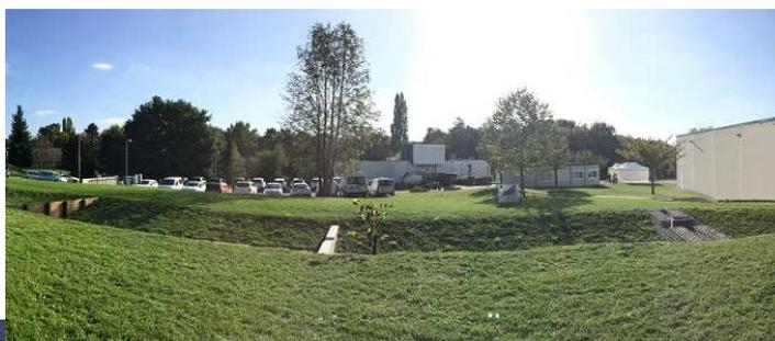
Il conviendra au pétitionnaire de garantir que les dispositifs de rétention/infiltration réalisés soient correctement dimensionnés en fonction du volume d'eau de ruissellement généré et des capacités précises d'infiltration des sols.
