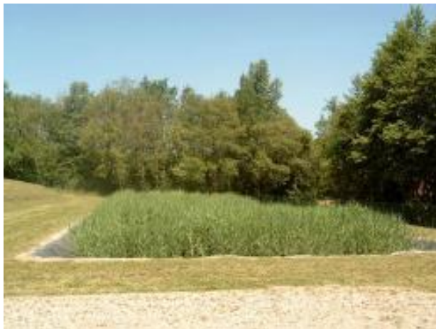
Station d'épuration de Lapeyrouse-Fossat, Source : Mairie de Lapeyrouse-Fossat
