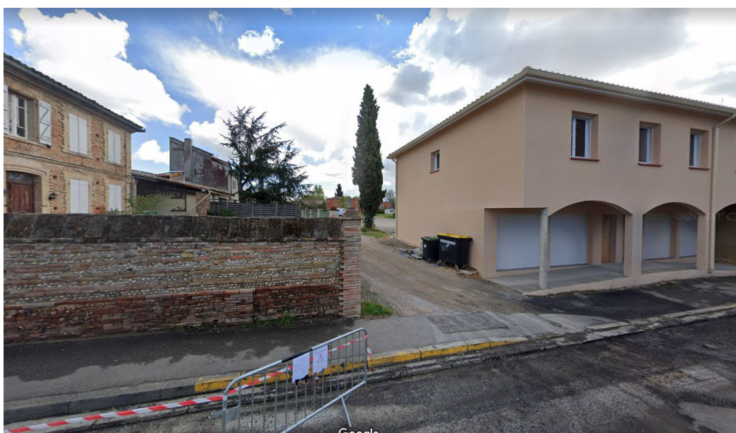
Vue 2 Vue de l'accès au tènement de l'OAP depuis la rue de la Poste. Accès de 5 mètres, dont l'aménagement sur l'espace public est sommaire.
