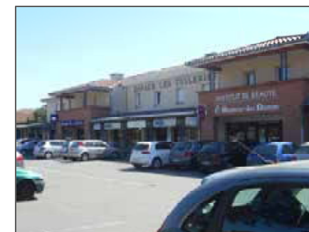
Espace commercial « les Tuileries »
