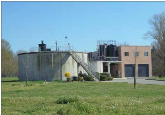
La station d'épuration de Pins-Justaret
