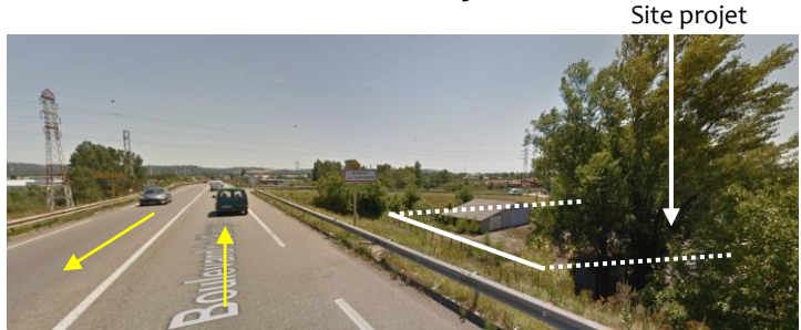
3- RD63 face au site du projet
