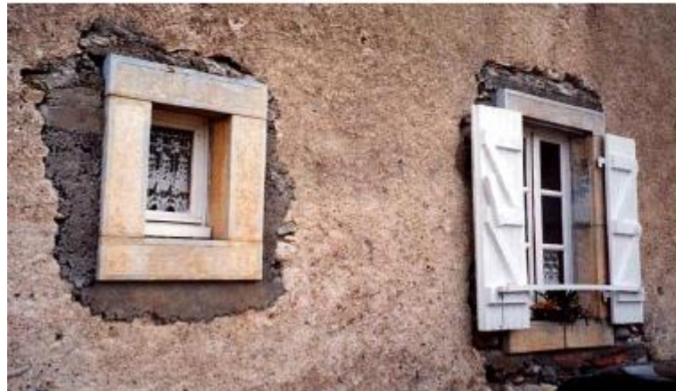
Détails d'ouverture en cours de restauration
