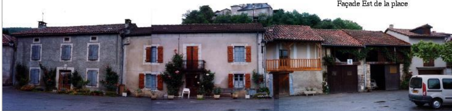
Façade Est de la place
