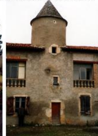
Tour médiévale de la maison Bordère
