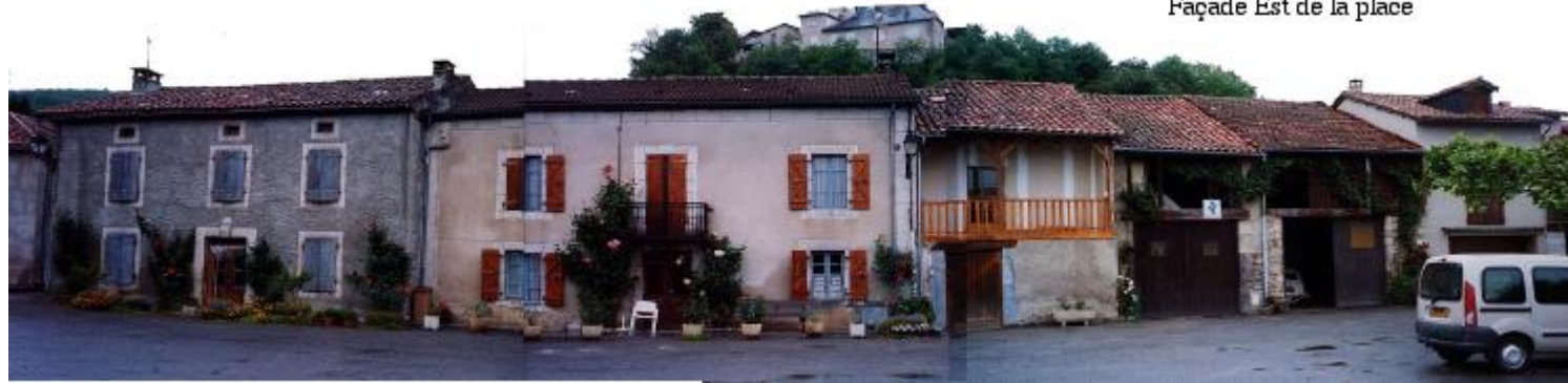
Façade Est de la place
