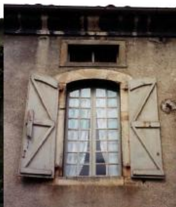
Détail d'une fenêtre et de la corniche en lattes plâtré
