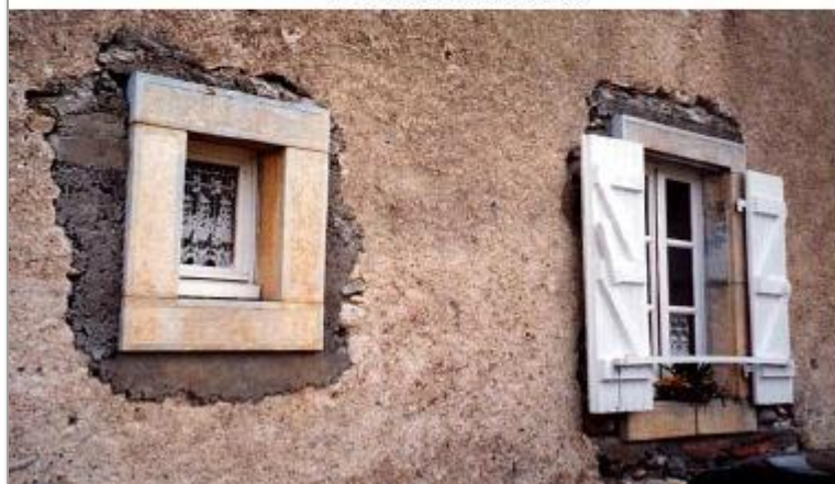
Détails d'ouverture en cours de restauration
