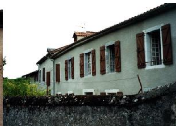
Parcelle n° 190, le long de la nouvelle voie qui conduit à Saint-Just de valcabrière
