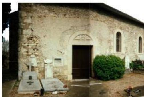
Vue du portail au Sud
