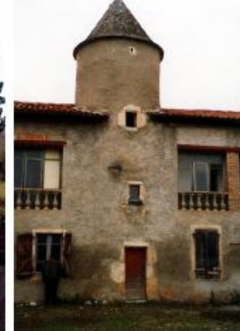
Tour médiévale de la maison Bordère
