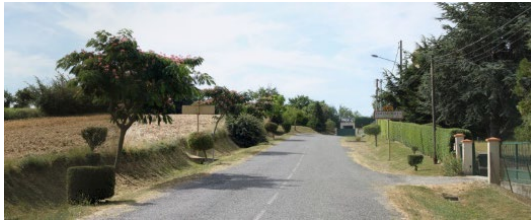
Entrée 4, Nord, par la RD91a Source : Artifex
