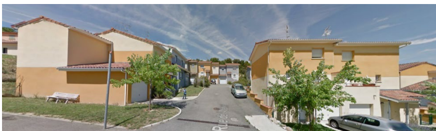
Figure 46 : logements sociaux Rue de l'Abetsens, source Google
