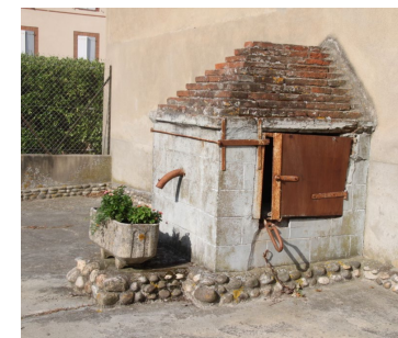
Puits couvert en cœur de Saint-Léon Source : Artifex
