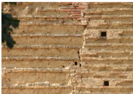
Mur de terre cuite et terre crue, Caussidières Source : Artifex
