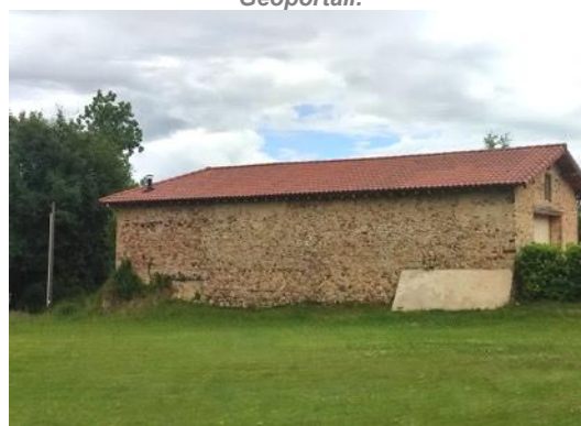
Illustration 44 : Bâtiment en pierre, photo prise le 11 juin 2024
