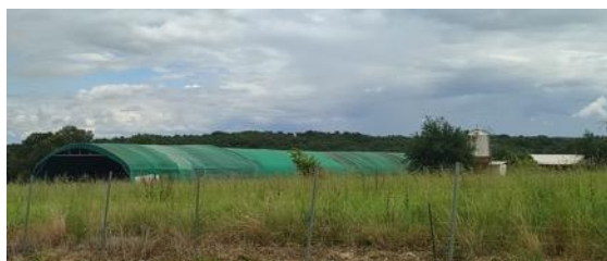
Illustration 49 : Bâtiment agricole, photo prise le 11 juin 2024
